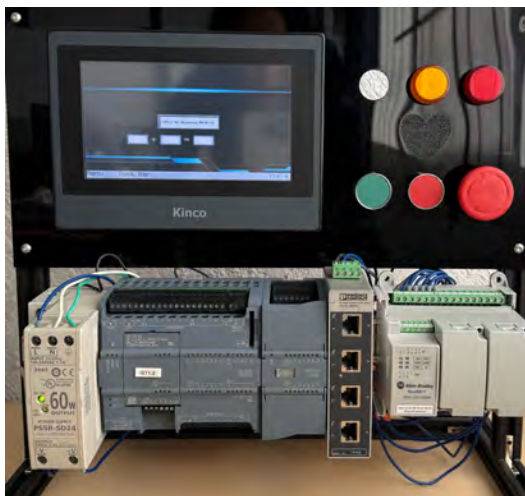
Construcción del Módulo didáctico
