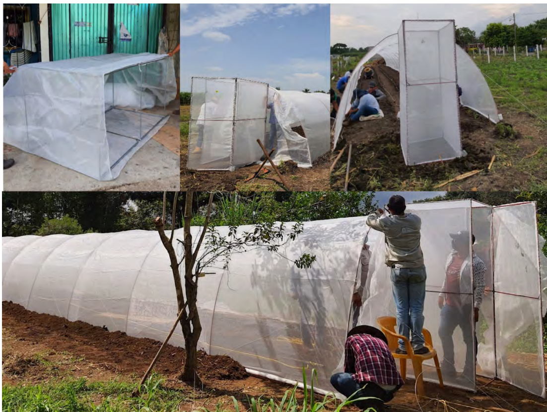
Figura 4.16. Colocación de la puerta de doble seguridad.
