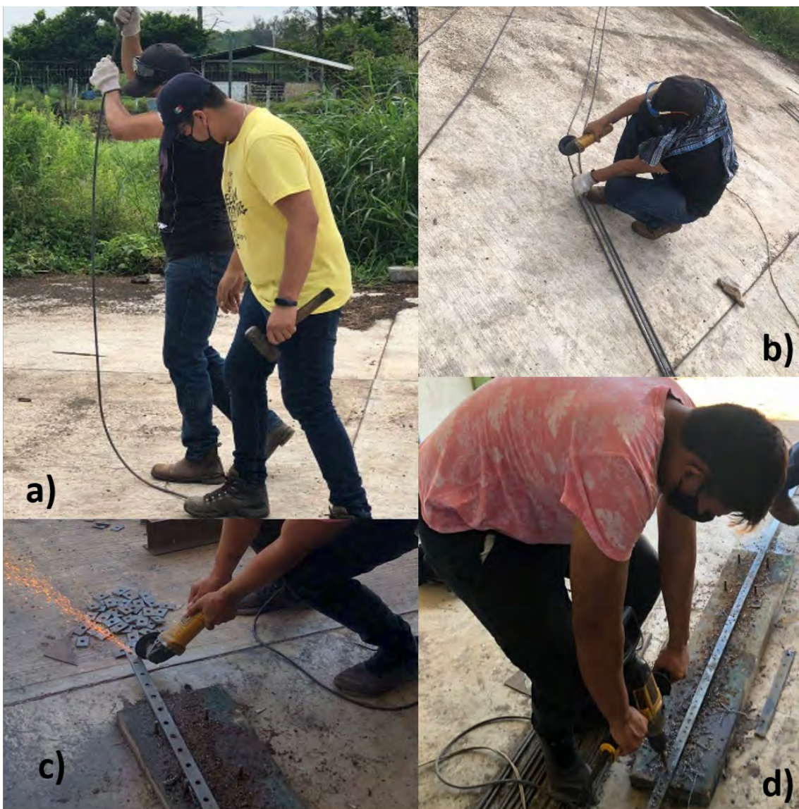
Figura 4.2. Preparación de los materiales para la construcción del macrotúnel. a) y b) Corte y enderezado de varillas; c) y d) corte de fragmentos de solera y perforación de las mismas.
