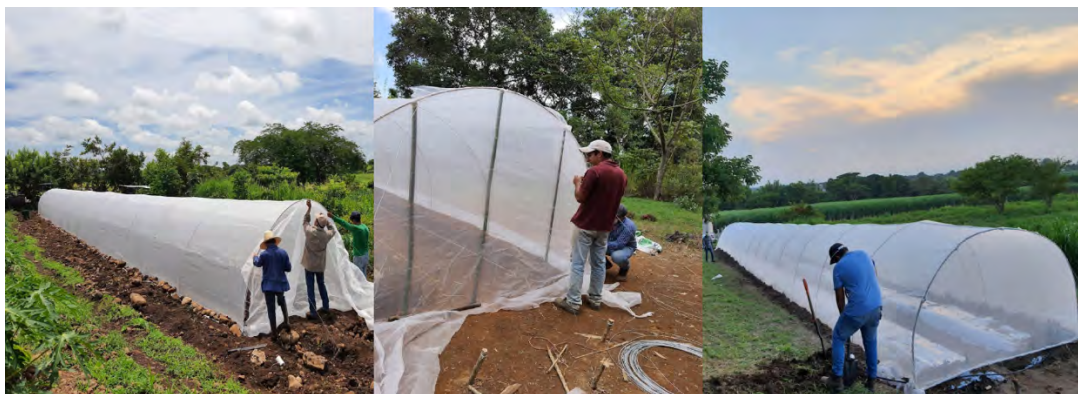
Figura 4.13. Colocación de la tapa del extremo posterior del macrotúnel.
