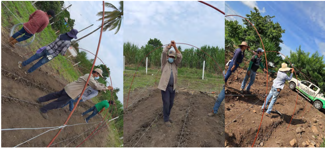
Figura 4.10. Amarre de los arcos con alambre galvanizado en la parte superior.
