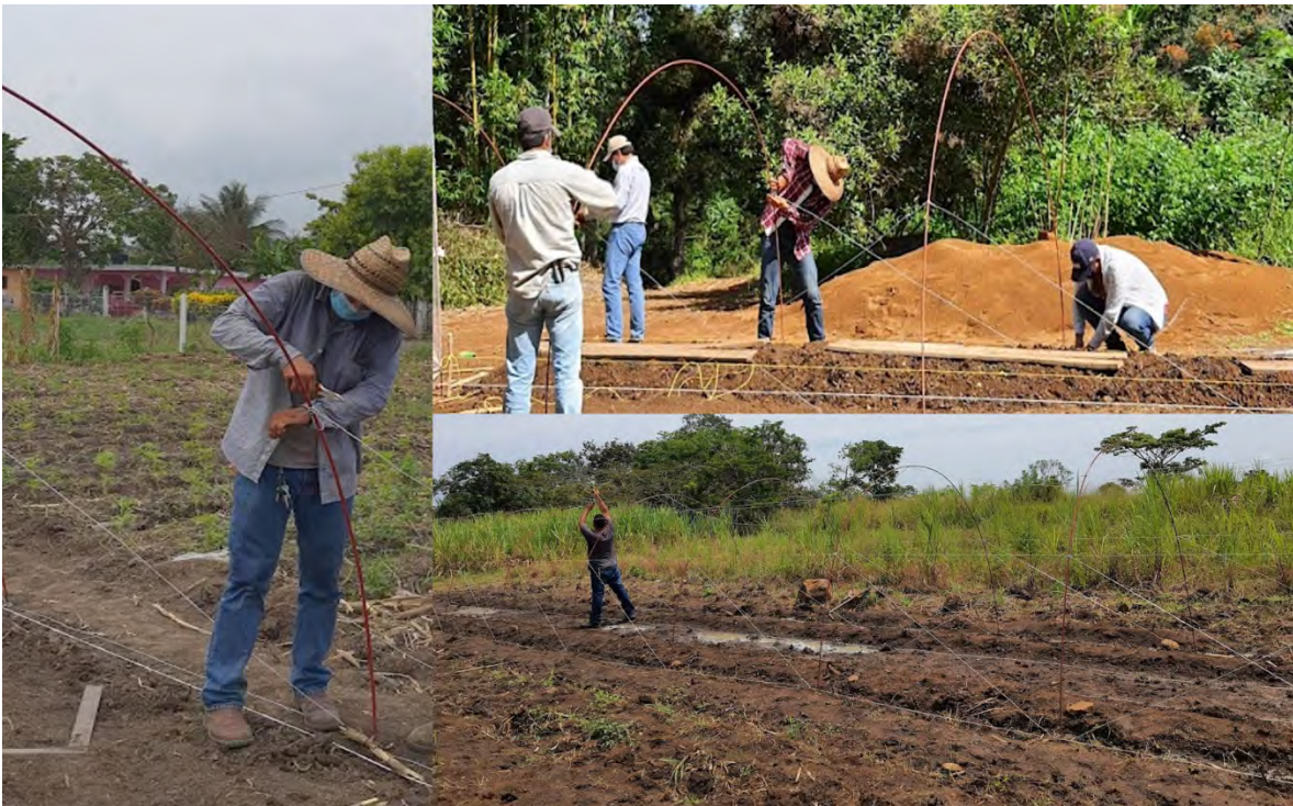
Figura 4.9. Amarre de los arcos con alambre galvanizado de forma cruzada.
