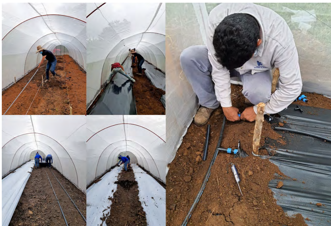
Figura 4.19. Instalación del sistema de riego y acolchado.
