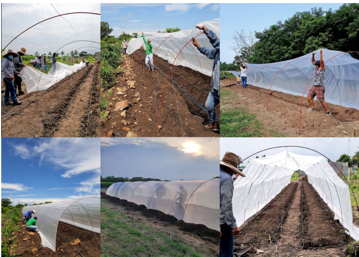
Figura 4.12. Colocación de la cubierta del macrotúnel.
