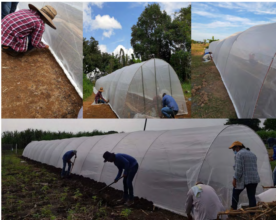
Figura 4.14. Tensado y cosido de la malla en la base del macrotúnel.
