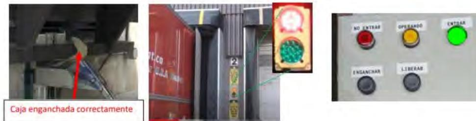
Imagen 20.- Caja enganchada correctamente.
