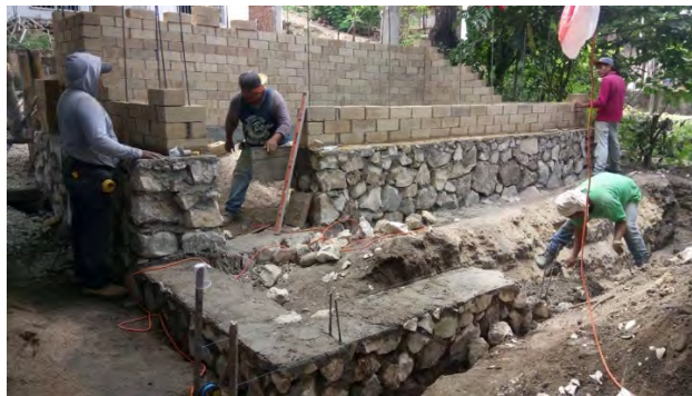
Figura 6. Proceso de construcción de vivienda con BTC y piedra del lugar en Los Sabinos, Berriozábal durante 2018.
