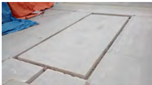
Figura 8 instalación de sistemas de drenado
