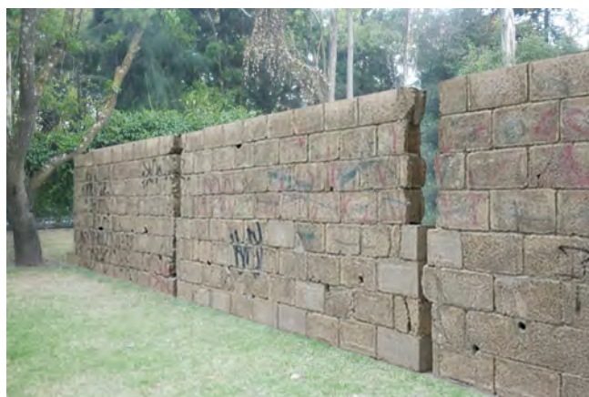
Ilustración 11. Muros evocadores del recuerdo de lo acontecido...
