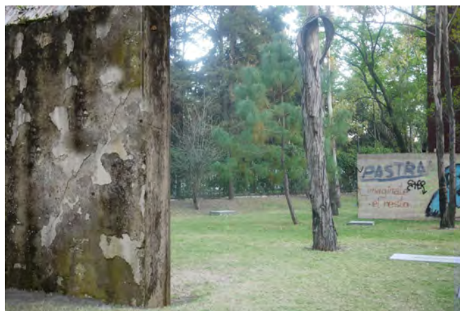
Ilustración 9. El muro testigo...
