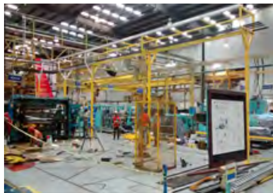
Figura 7 instalación de servicios auxiliares
