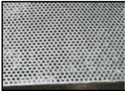
Figura 9. Agujeros obstruidos (CEMESA Galvanizadora, 2015).
