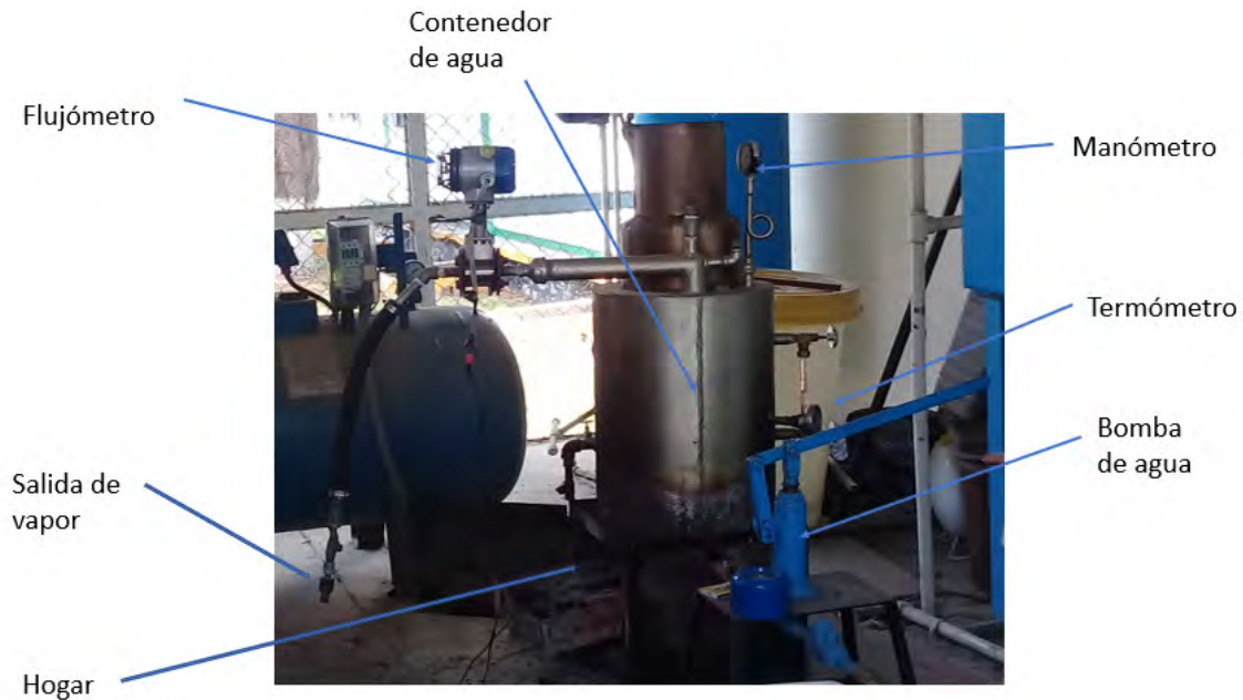
Figura 1. Sistema de Generación de Vapor y sus componentes
