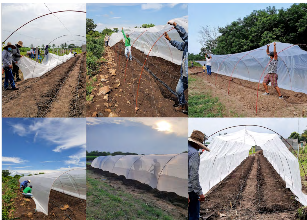
Figura 4.12. Colocación de la cubierta del macrotúnel.
