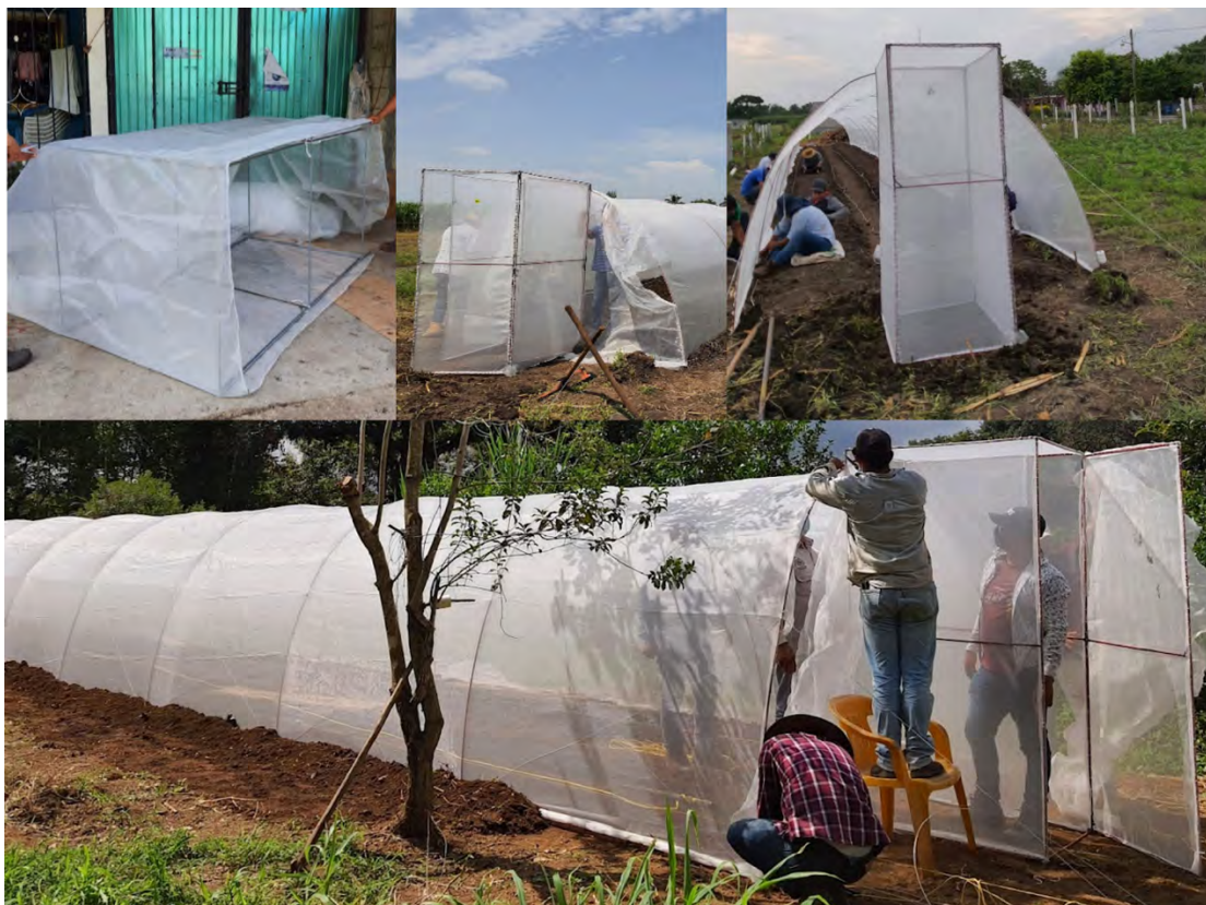
Figura 4.16. Colocación de la puerta de doble seguridad.
