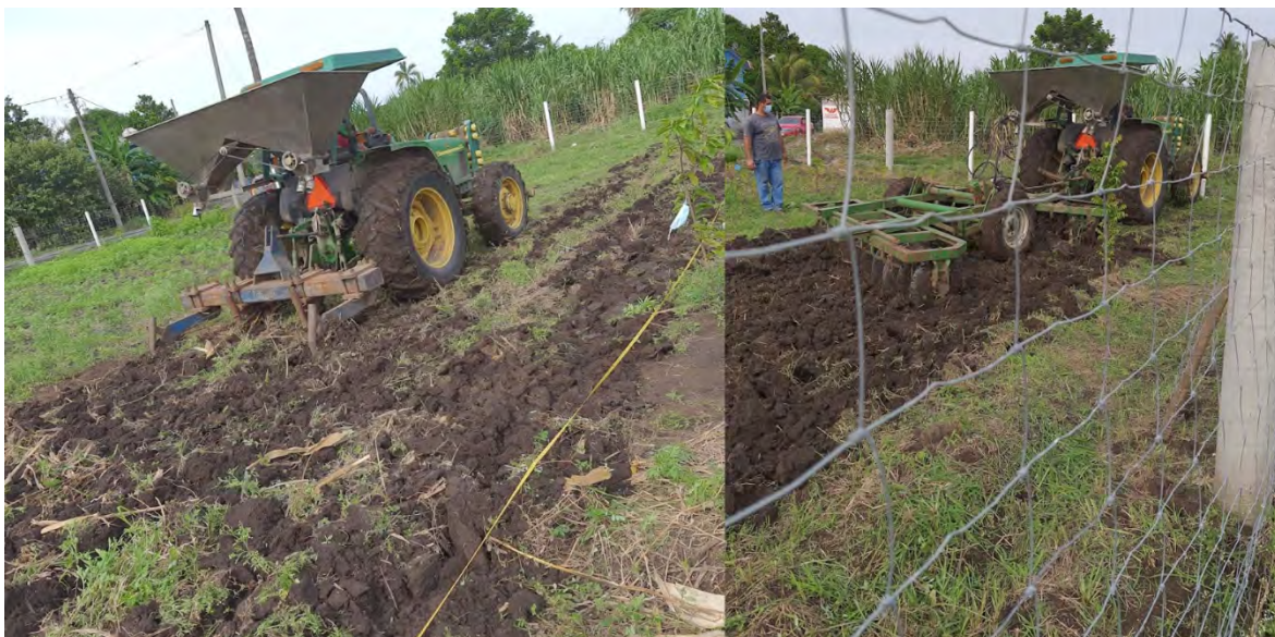
Figura 4.3. Acondicionamiento del área.
