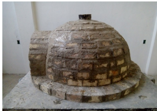
Figura 14. Horno terminado con materiales refractarios
