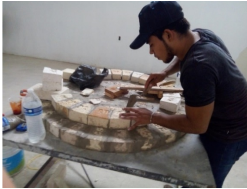
Figura 11. Construcción de la cúpula del horno.
