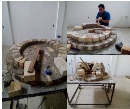
Figura 12. Avance de la Construcción del Horno.
